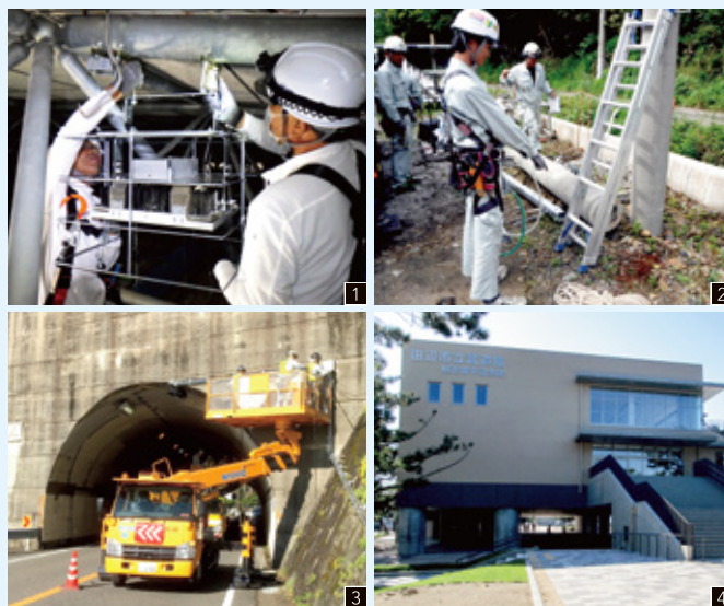
1 LED照明取り付け作業状況 2 柱上訓練の様子 3 トンネル杭口配管作業に従事 4 田辺市武道館の機械設備工事も担当
